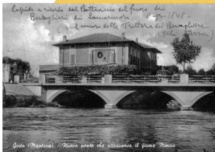
Goito (Mantova) - Nuovo ponte che attraversa il fiume Mincio
